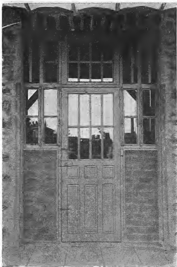
FIG. 27. — Portique extérieur (salles de réunions, dortoirs, réfectoires, ateliers, chambres).
